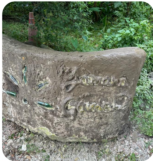
將外層敲除後，塗抹 石灰混合發酵馬糞
